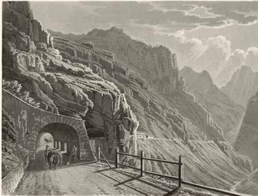
Gallerie al Rio di Peder, unterhalb dem Wirthshaus Spondalunga, nach Bormio gehend.
