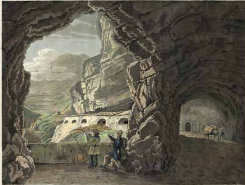
Vom Innern der dritten Gallerie in Vallone della neve gegen des Wirtshauses Spondalunga.
