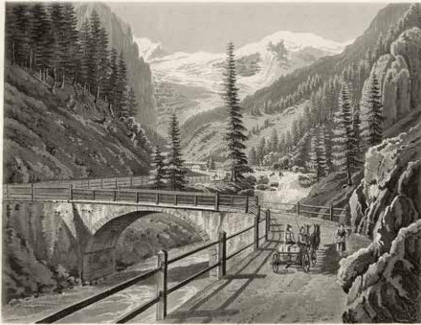
Zweyte u. dritte Brücke unterhalb Trafoi. Second et troisième Pont au dessous de Trafoi.
